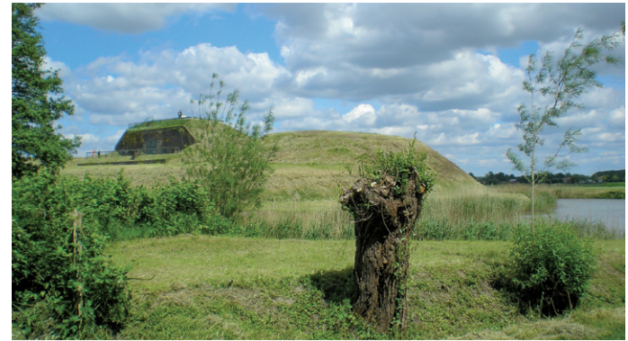
Werk aan de Waalse Wetering
