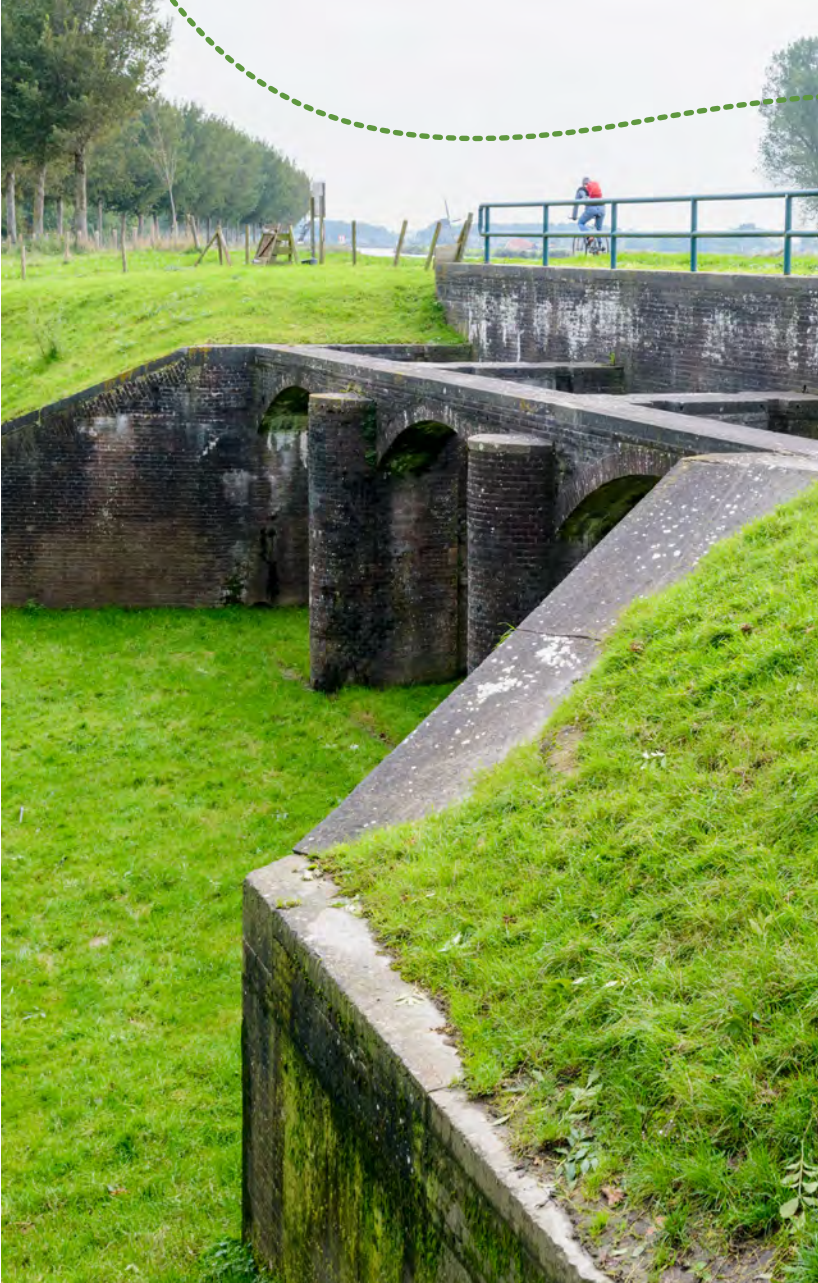
Inundatiesluis Zuidelijke Beemsterringdijk - Martin van Lokven
