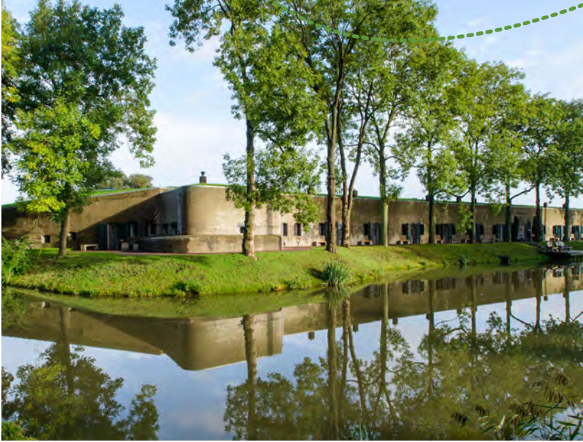
Fort aan de Nekkerweg (Fort Resort Beemster) - Martin van Lokven
