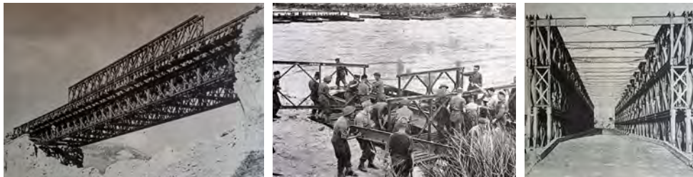
BOVEN Links: Baileybrug afwateringskanaal | Rechts: radiopost 5e Seaforths in de Duinen | ONDER voorbeelden Baileybrug.
