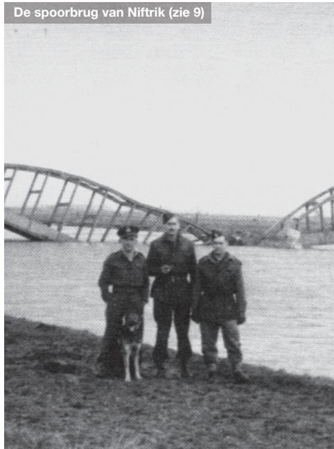
De spoorbrug van Niftrik (zie 9)
