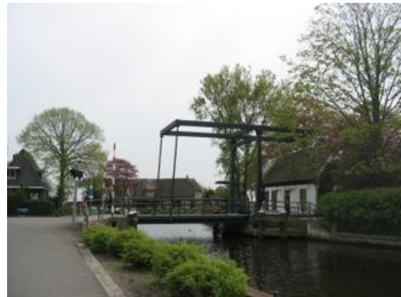
De brug in Bilderdam
