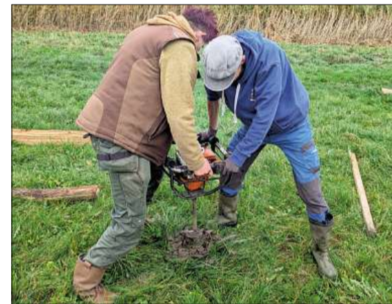
Ökowerk-Gärtnerin Heidi Schwarze und ihr Kollege Torsten Duchow griffen zum Erdbohrer, um Löcher für die Pfähle der Totholzhecke auszuheben.
