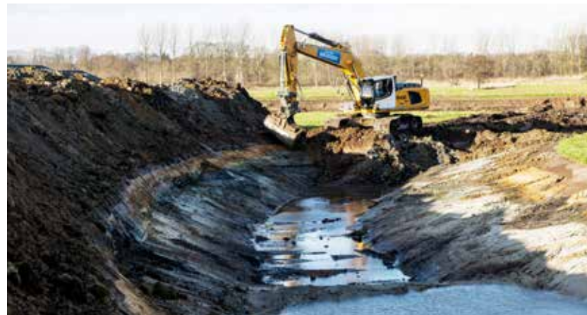
▲ Herstelwerkzaamheden hermeandering Essche Stroom
