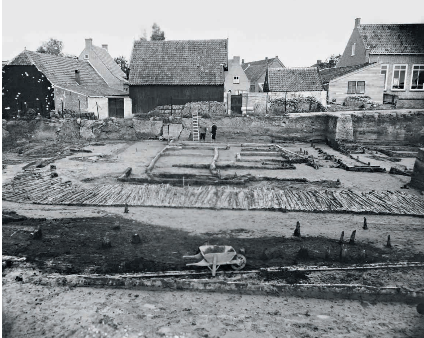
Opgraving van de noordwesthoek van het fort in Valkenburg (ZH) in 1942
