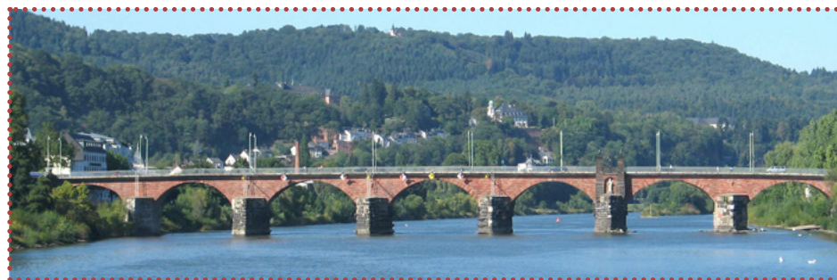
Deze Romeinse brug ligt in Trier in Duitsland. De brug is nog steeds in gebruik.
