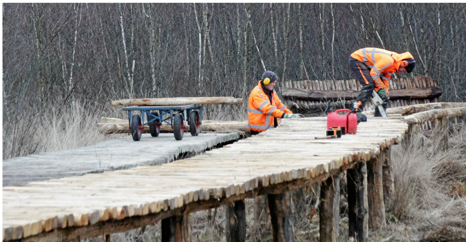
Arbeiter legen einen neuen „Knuppelpfad“ an, so kommen Spaziergänger auf trockenen Füßen durch das Moorgebiet.
