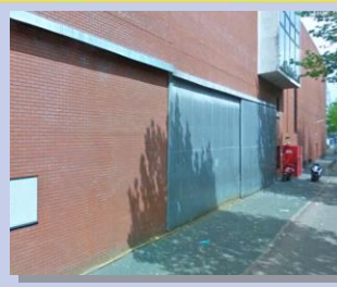
Laad en losperon / Lift Middenzaal
