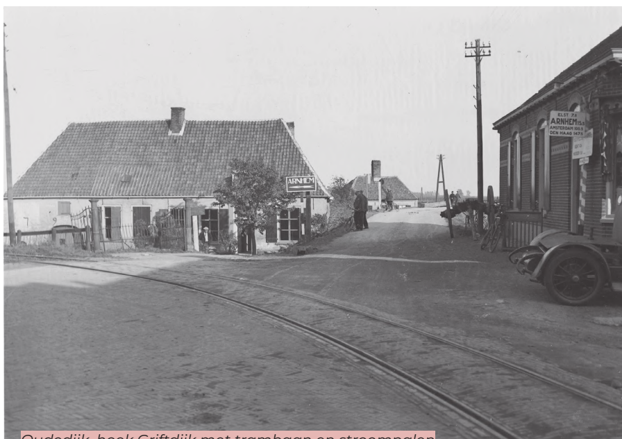
Oudedijk, hoek Griftdijk met trambaan en stroompalen
