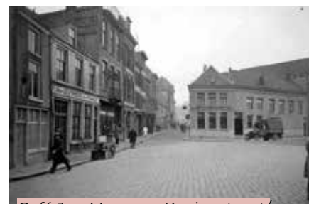
Café Jan Meussen, Koningstraat/hoek Ziekerstraat 1930, het hele pand is in 1950 afgebroken om meer ruimte te maken voor het Koningsplein.
