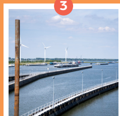
Volkeraksluizen in Willemstad
