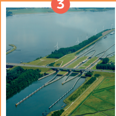
Volkeraksluizen in Willemstad
