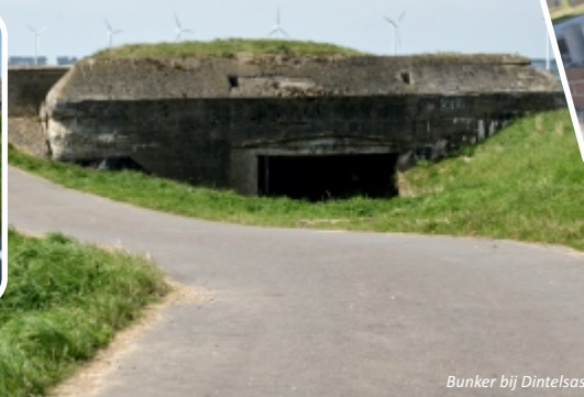
Bunker bij Dintelsas
