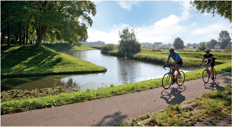
De vestingwerken aan de zuidkant van Klundert
