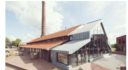
voorbeeld van een herbestemde steenfabriek met behoud van het industriële karakter bij Panningen
