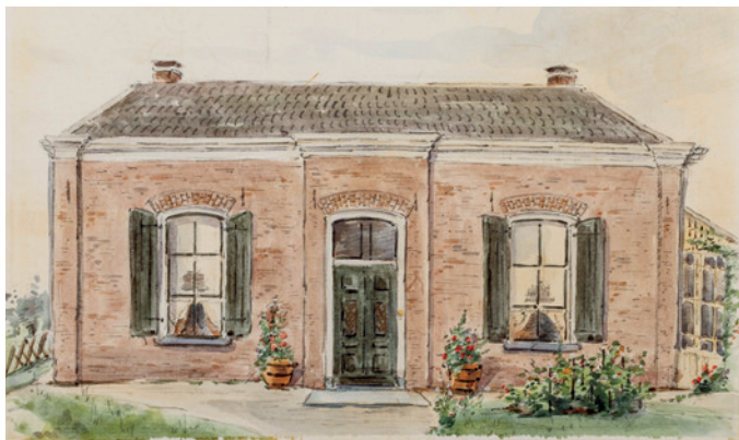
Oorspronkelijke woning. Bron: RAZU
