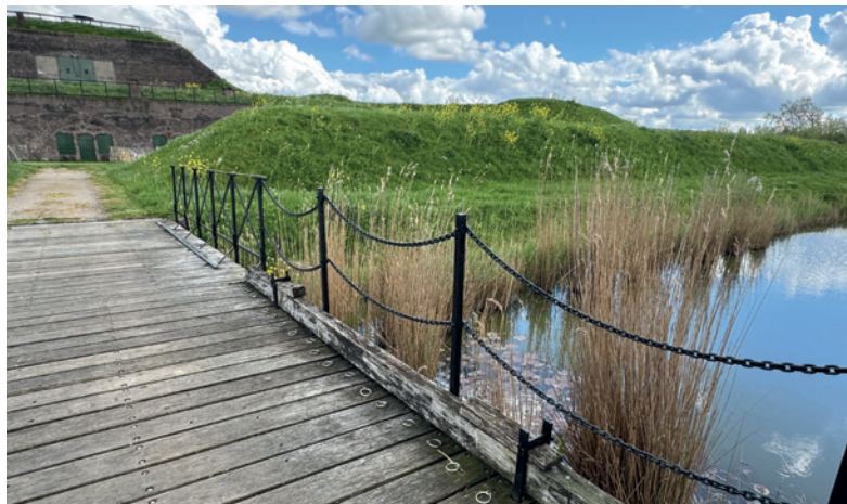
Werk aan de Waalse Wetering – brug met losse planken, voorjaar 2026 (foto Pieter Buisman)
