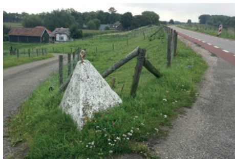
Tetraëder met hijsoog aan de Lekdijk bij de Groeneweg. Bron: Watererfgoed HDSR.
