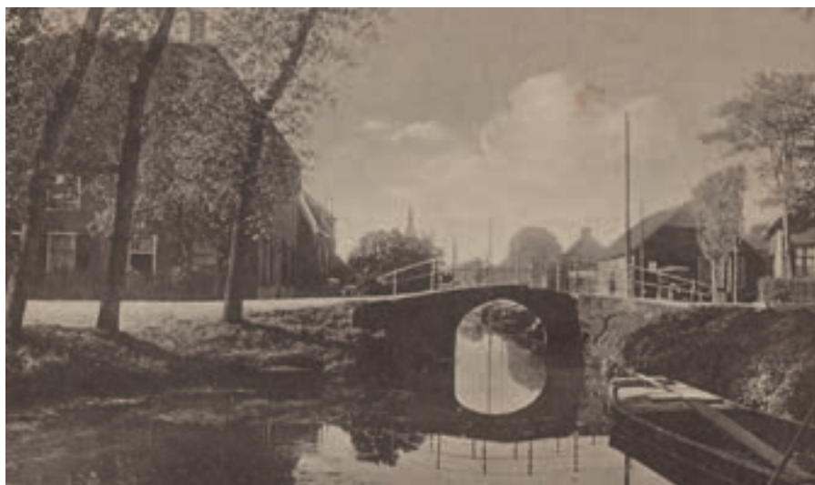
Figuur 4: Brug over de Schalkwijkse wetering met op de achtergrond de doorrijschuur
