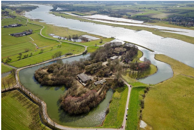
Afb. 1 Fort Honswijk langs de Lek. Het fort is eigendom van de gemeente Houten en wordt ontwikkeld als gastvrije en ondernemende community. Bron: Aerophoto Schiphol/Hollandsewaterlinies.nl
