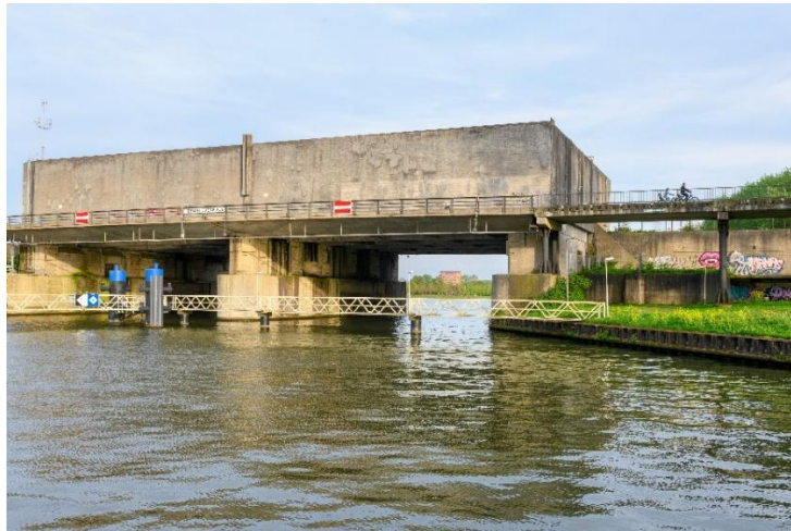
Afb. 1 De Plofsluis in het Amsterdam-Rijnkanaal bestaat uit vijf grote betonnen bakken met grind en puin. Bij oorlogsdreiging kon de bodem worden opgeblazen, zodat de inhoud in het Amsterdam-Rijnkanaal stortte. Zo werd het kanaal afgedamd en kon worden voorkomen dat bij inundatie het water uit omliggende gebieden wegstroomde. Bron: Hollandse Waterlinies/Martin van Lokven
