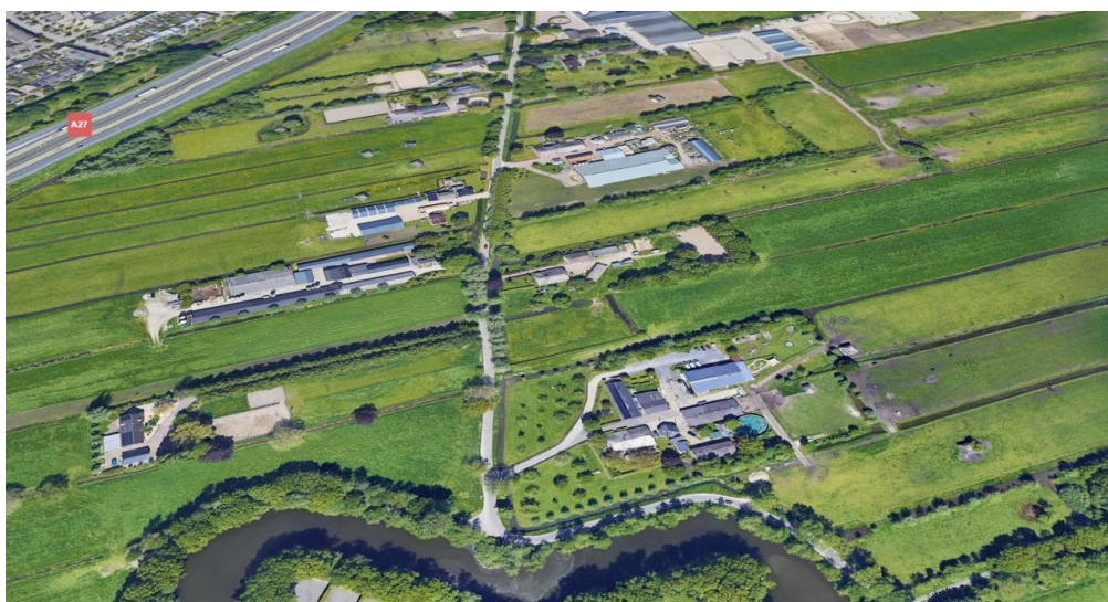
Afb. 5 Vogelvuchtfoto van Fort Voordorp richting de A27. Het acces Voordorpse Dijk (midden) was de hoofdverdedigingslijn in WO II. Links en rechts ervan liggen meerdere groepsschuilplaatsen. Bron: Google Earth
