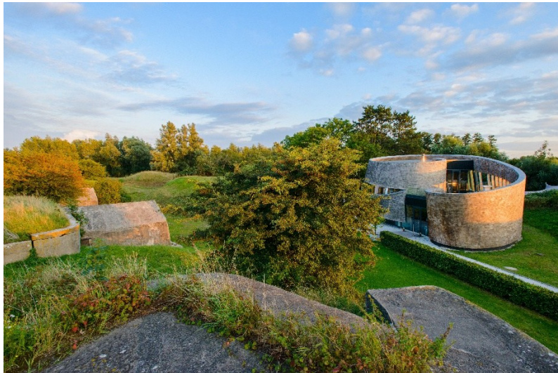
Afb. 1 Kustbatterij bij Diemerdam, officiële naam Werk aan het IJ voor Diemerdam. Tegenwoordig in gebruik als trouw- en evenementenlocatie. Bron: Hollandse Waterlinies/Martin van Lokven
