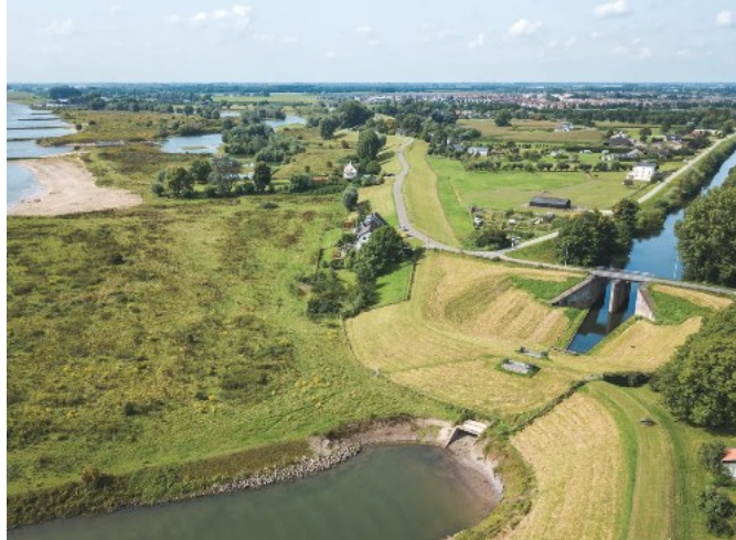
Afb. 1 Hoofdinlaatsluis van het inundatiekanaal Tiel bij het toevoerkanaal vanaf de Waal. Bron: Hollandse Waterlinies/Pim van Schaik
