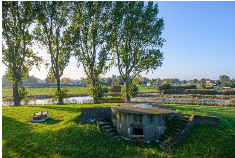
Afb. 1 Hefkoepelgebouw van Fort bij Aalsmeer, met op de achtergrond een schip op de Ringvaart van de Haarlemmermeerpolder. Bron: Hollandse Waterlinies/Martin van Lokven
