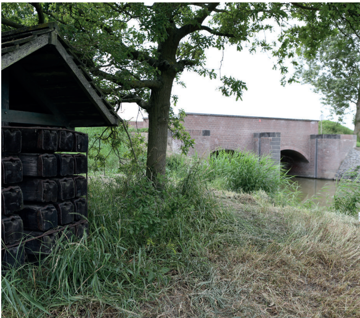
Damsluis met schotbalkenloodsen in de Molentocht bij de Vuurlinie in de Wijkermeerpolder (foto Kenneth Stamp, bron: https://www.stellingvanamsterdam.nl/nl/toolkit/fotos ).
