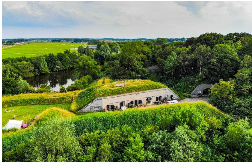
Afb. 1 Fort bij Abcoude. Het fort is eigendom van Natuurmonumenten en sinds eind 2025 gesloten wegens werkzaamheden. Bron: Hollandse Waterlinies/Jessica de Korte
