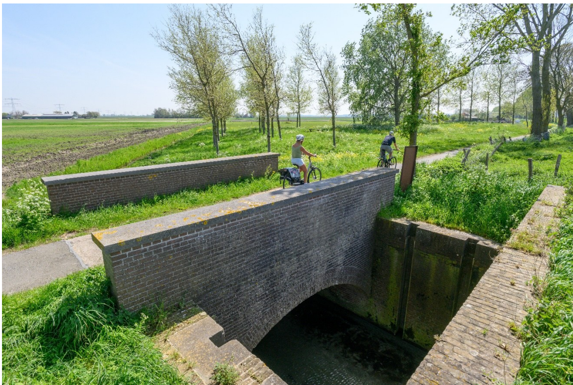
Afb. 5 De damsluis in de Wijkertocht is een provinciaal monument. Bron: HollandseWaterlinies/Martin van Lokven
