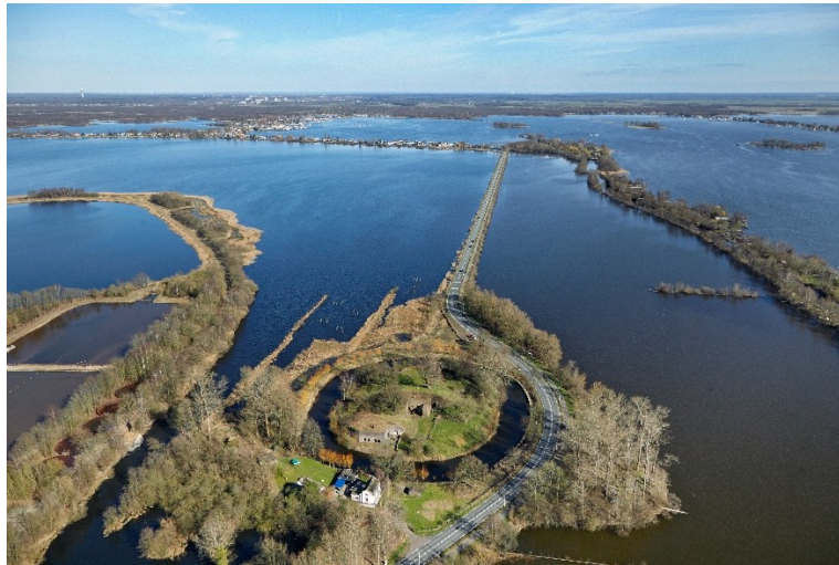
Afb. 1 Fort Spion, aangelegd tussen 1844-1847 ter verdediging van de weg (het acces) tussen Loosdrecht en Loenen aan de Vecht. Midden op de Bloklaan werd een rond forteiland aangelegd. De doorgaande weg werd om het fort heen geleid. Bron: Hollandse Waterlinies/Aerophoto Schiphol
