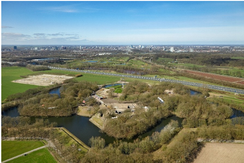
Afb. 1 Fort Vechten: een unieke plek op het knooppunt van twee werelderfgoederen, de Hollandse Waterlinies en de Neder-Germaanse Limes (links het Romeinse Fort Fectio). Fort Vechten is eigendom van Staatsbosbeheer. Het is in gebruik als evenementenlocatie en herbergt het Waterliniemuseum. Bron: Hollandsewaterlinies.nl/Aerophoto Schiphol
