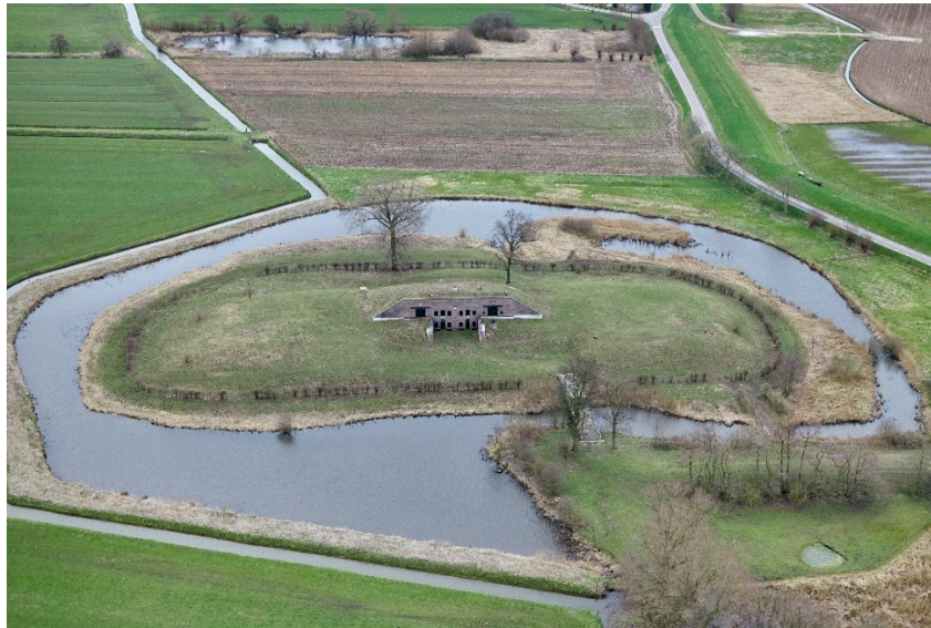
Afb.5 Batterij onder Poederijen, momenteel in gebruik als brasserie, trouw- en feestlocatie. Het fort diende samen met tweelingfort Batterij onder Brakel als verdediging van Slot Loevestein en de vesting Woudrichem. Bron: Hollandse Waterlinies/Aerophoto Schiphol
