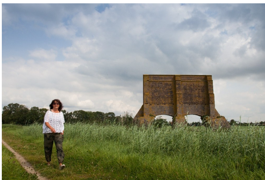
Afb. 6 Kogelvanger in het weiland ten zuiden van Werk aan het Spoel. De zeven meter hoge bakstenen muur stond aan het eind van een (inmiddels verdwenen) schietbaan en ving de kogels op die het doel niet hadden geraakt. Bron: Hollandse Waterlinies/Desiree Meulemans
