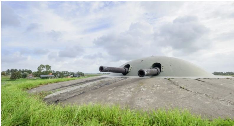
Afb. 1 Fort bij Spijkerboor in de Beemster, buurgemeente Purmerend. De verboden kringen van het fort liggen deels in Wormerland. Bron: Hollandsewaterlinies.nl
