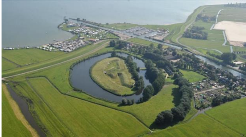
Afb. 1 Fort bij Edam, nu beschermd natuurgebied en beperkt toegankelijk Bron: Google Earth
