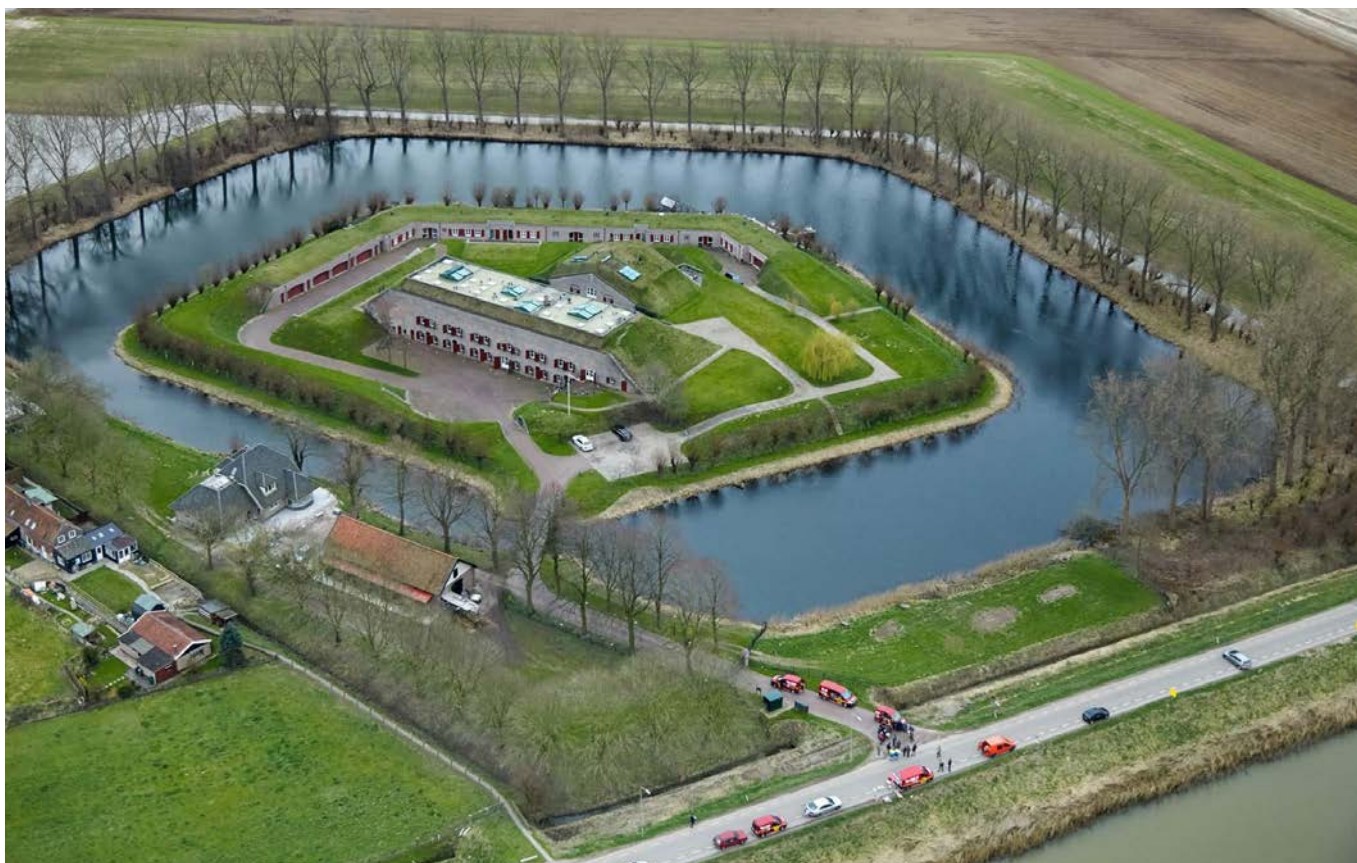
Wonen op Fort bij het Steurgat (bron: beeldbank Kenniscentrum Waterlinies, 2023)
