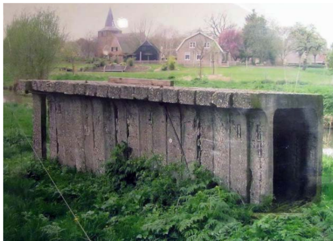
Moot-schuilplaats; betonnen segmenten bij elkaar gehouden door stalen stangen (bron: wilhelminasluisandel.nl)
