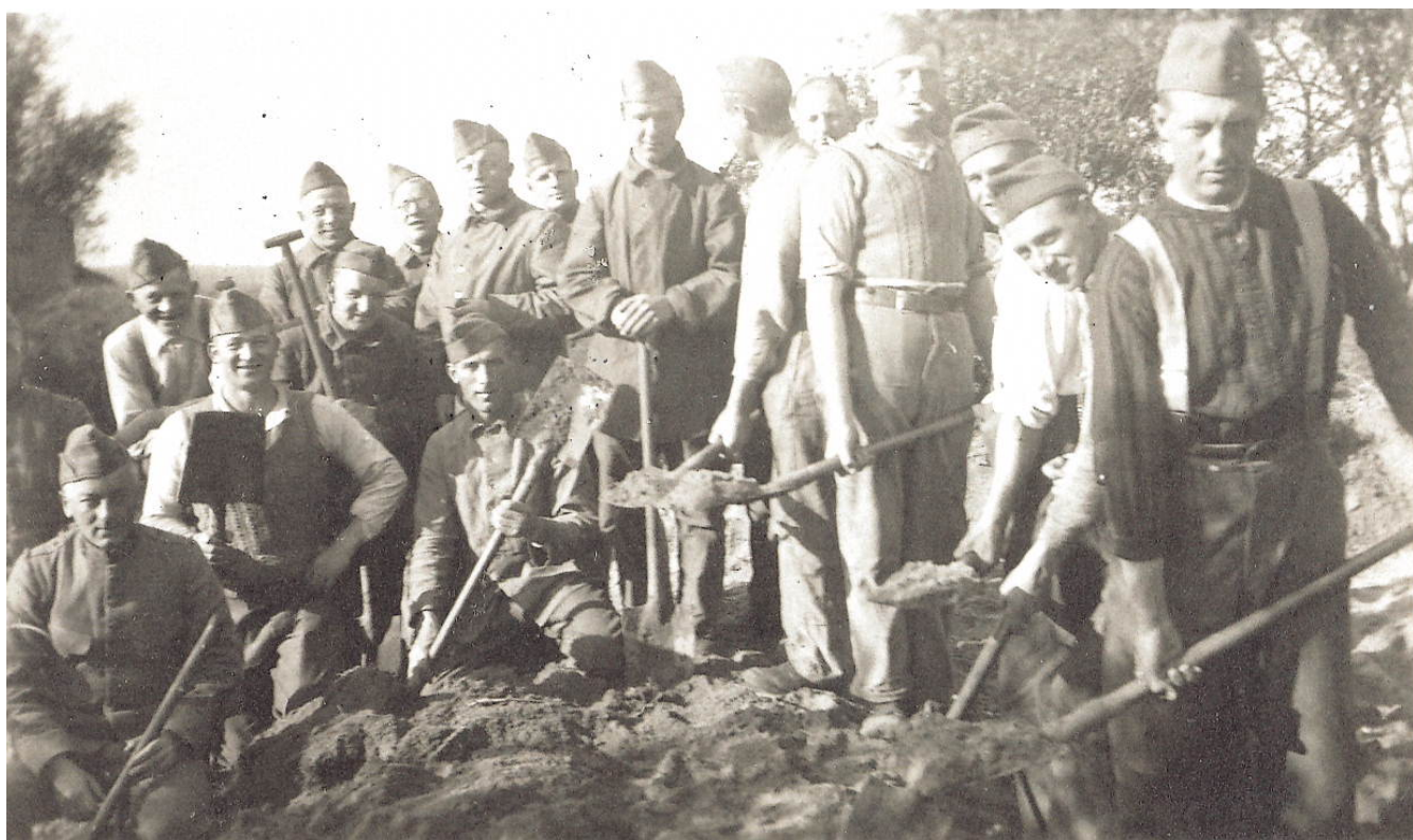
Soldaten werken aan het aanleggen van loopgraven, 1939-1940 (bron: Hollandse Waterlinie Erfgoedreeks Fort Altena)
