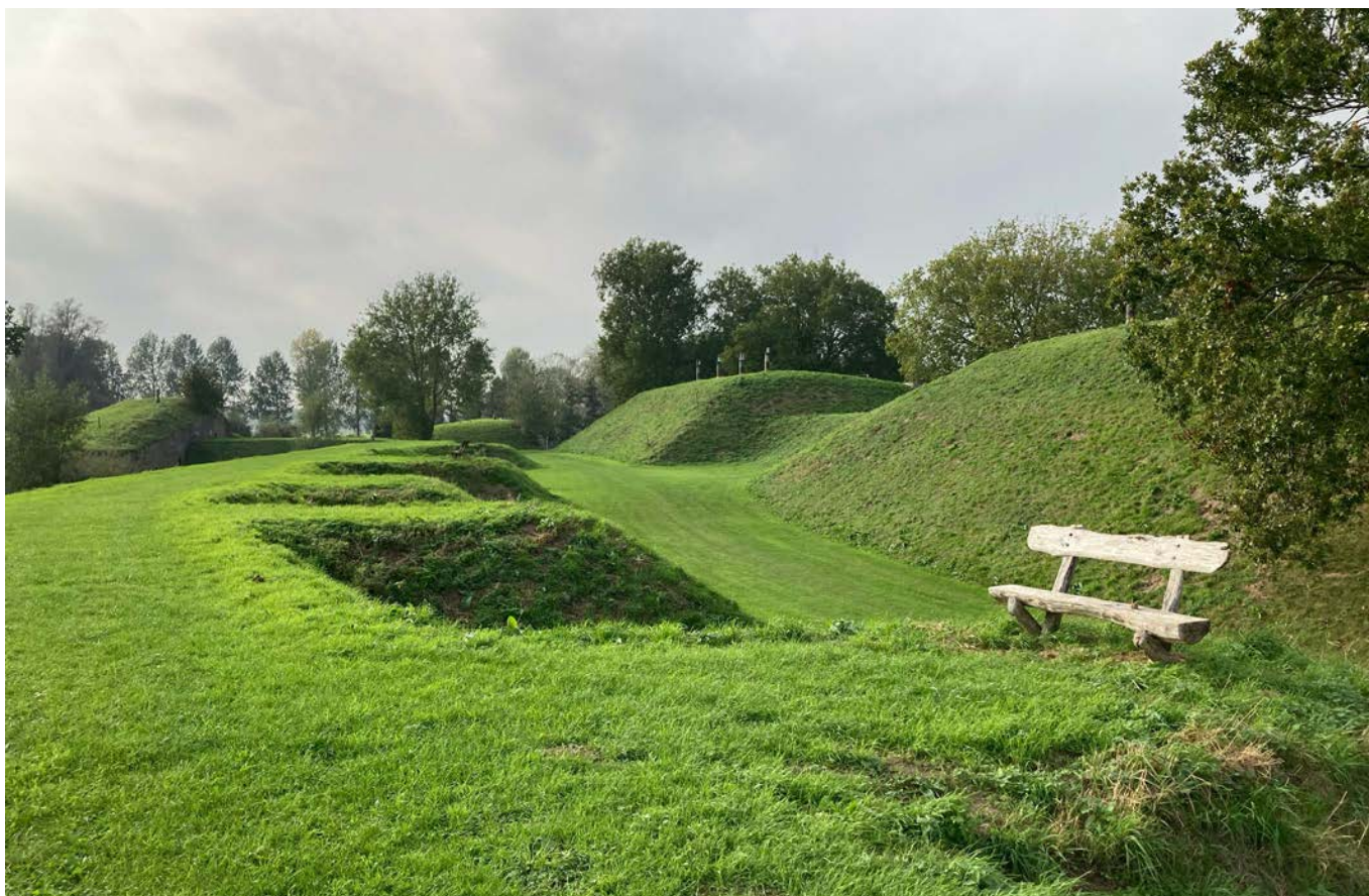
Foto van de gereconstrueerde aarden omwalling van Fort Altena met opstelplaatsen voor geschut en de gracht aan de linkerzijde. Aan de rechterzijde de omaarde bomvrije gebouwen (2023)
