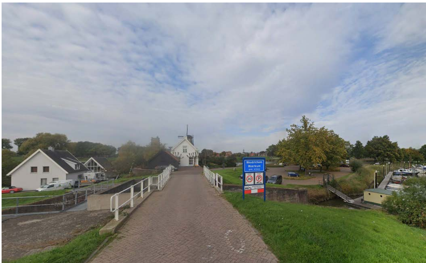
Hoofdinlaat Woudrichem; rechts het toevoerkanaal, in het midden de waaiersluis, links de kwelkom en op de achtergrond de sluiswachterswoning (Googlemaps, 2023)
