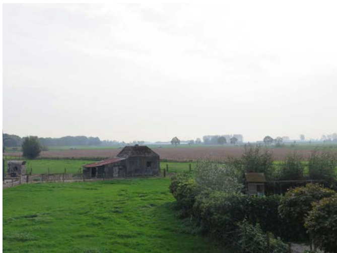
Schuilplaats type P met aanbouw nabij Schansedijk (2023)
