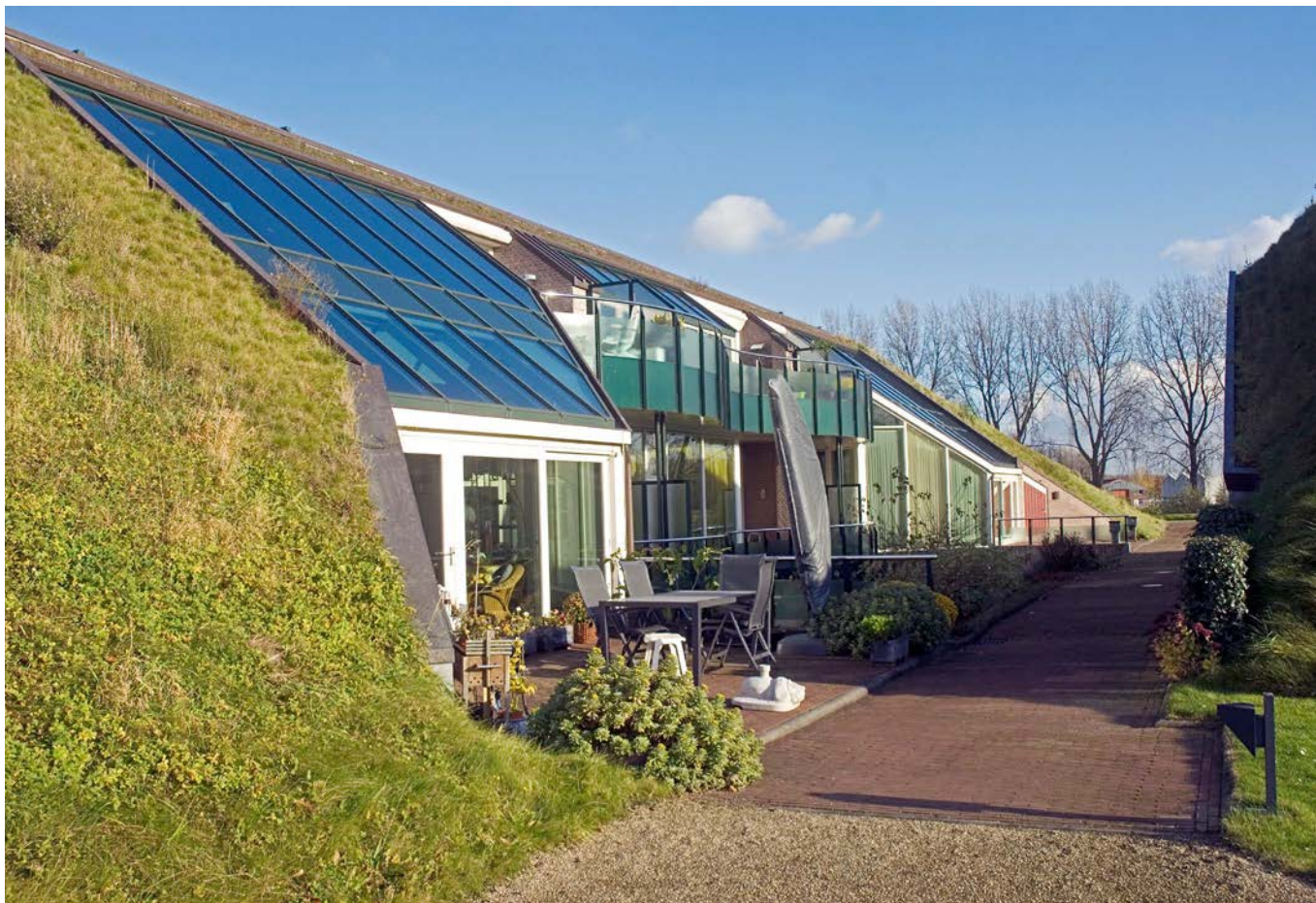
Wonen op Fort bij het Steurgat (bron: beeldbank Kenniscentrum Waterlinies, 2023)
