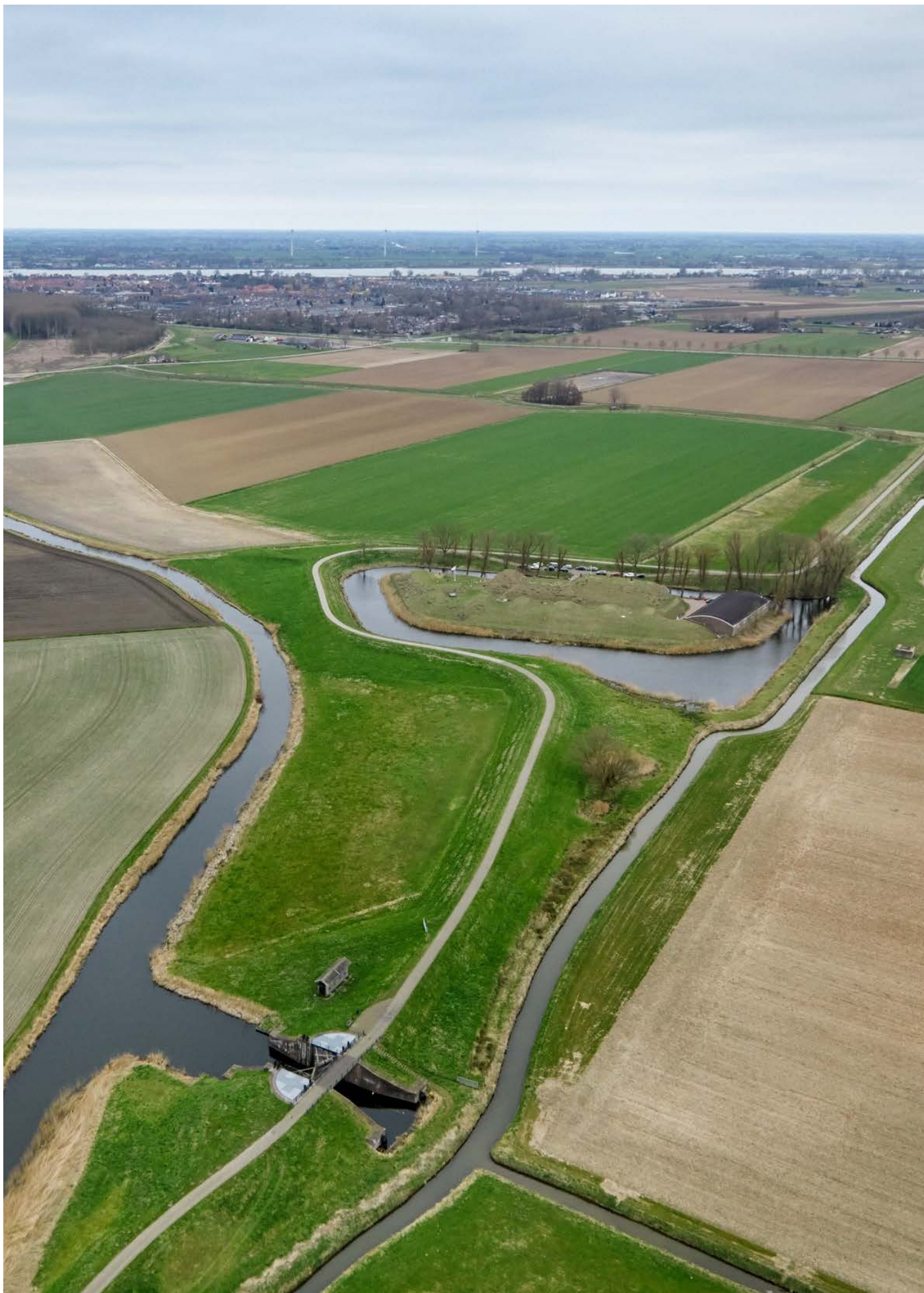
Luchtfoto Werk aan de Bakkerskil en Papsluis, 2015. (bron: beeldbank Kenniscentrum Waterlinies, 2023)
