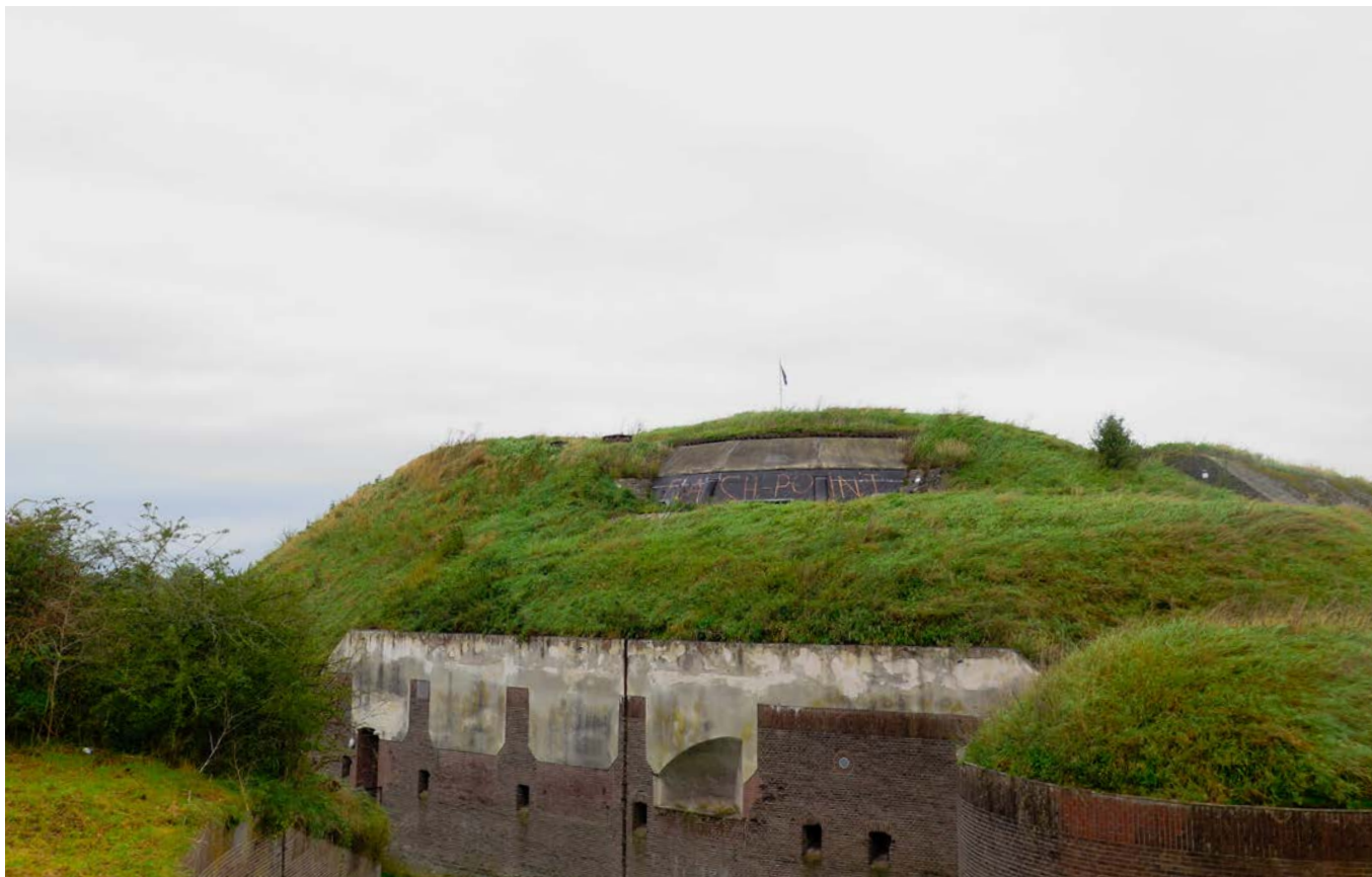
Periode aanleg Nieuwe Hollandse Waterlinie, 1885 - 1890; Fortuitbreiding met pantserbatterijen (2023)
