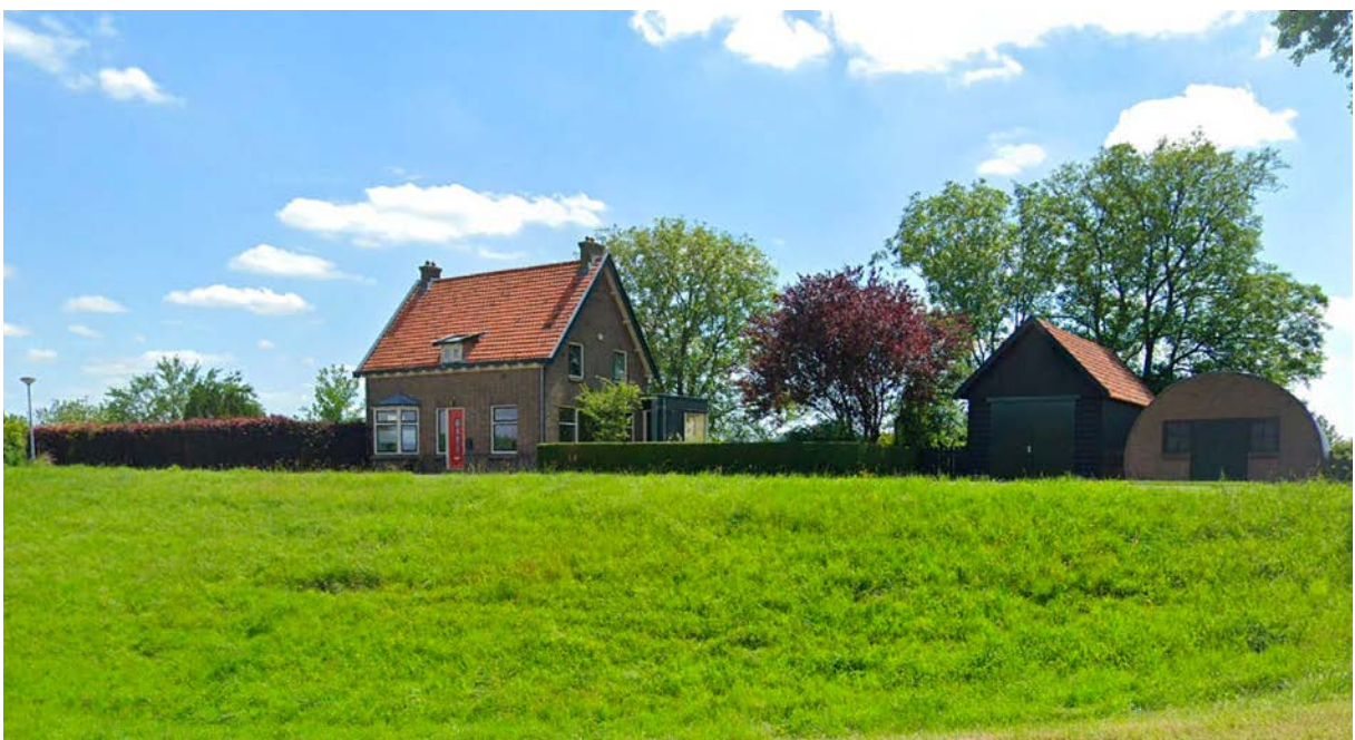
Foto van de sluiswachterswoning, schotbalkloods en Romneyloods (bron: google.com/maps)
