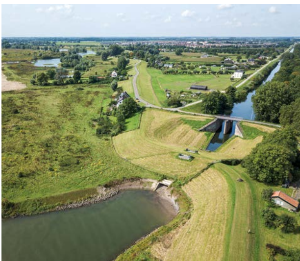
Foto van overgebleven elementen van de inlaatsluis aan de Waal (bron: kenniscentrumwaterlinies.nl)
