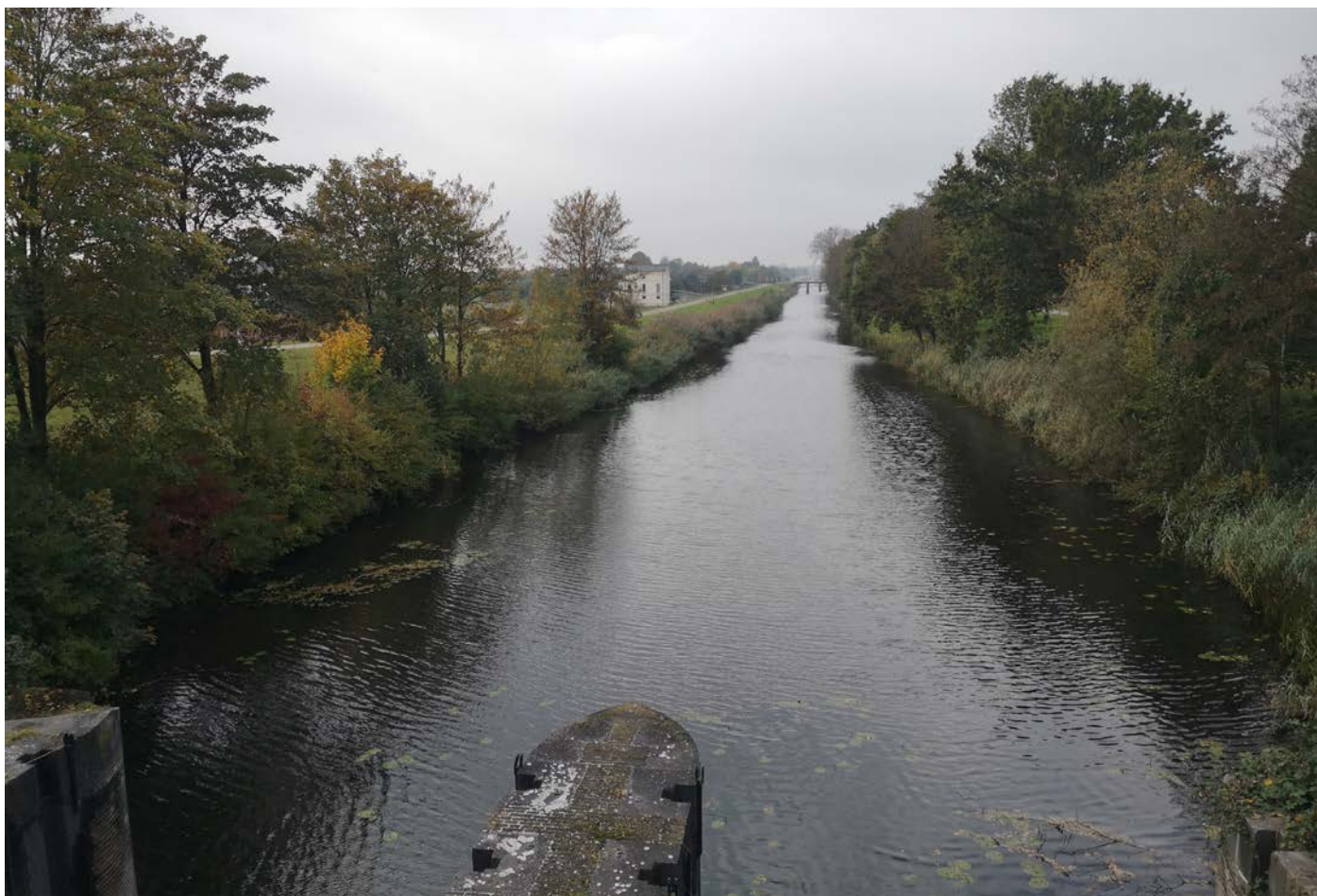
Foto van het inundatiekanaal vanaf de oorspronkelijke inlaatsluis (Ophemertsedijk, Bandijk): Het inundatiekanaal vormt een rechte lijn door het landschap. De rechterzijde is de noordkant van het kanaal, dat gekenmerkt wordt door een meer parkachtig karakter. (2023)
