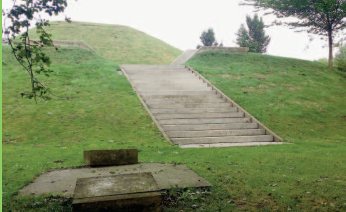
Voorbeeld 2: Fort Werk aan het Spoel 2012
