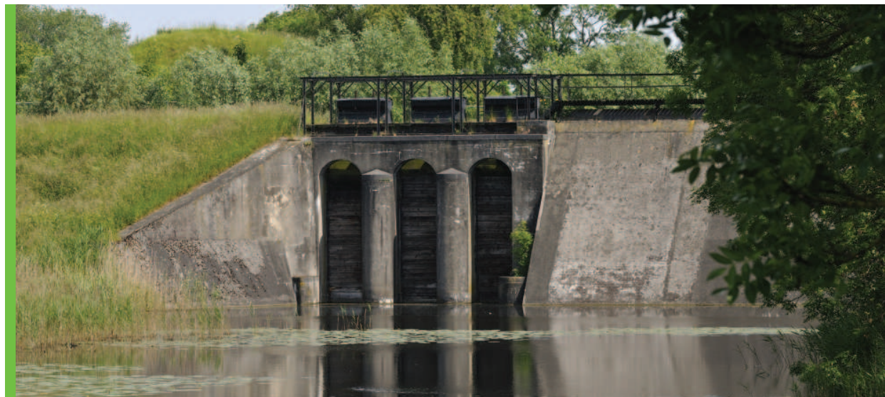
beersluis bij Fort bij Everdingen
