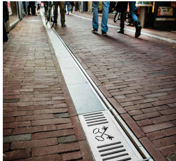
Voorbeeld van een centrale lijngoot, Donkersteeg in Leiden
