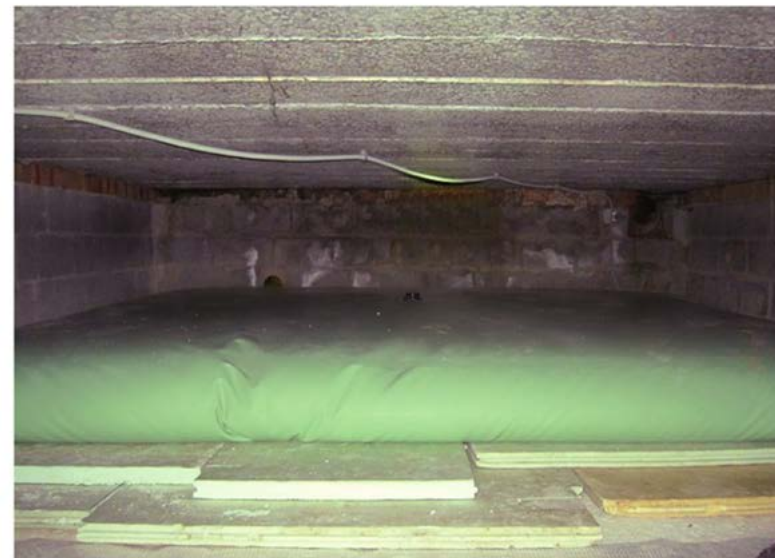
Het EFrarain-regenwatersysteem vangt regenwater op en zet het in voor toiletspoeling, wasmachine en
