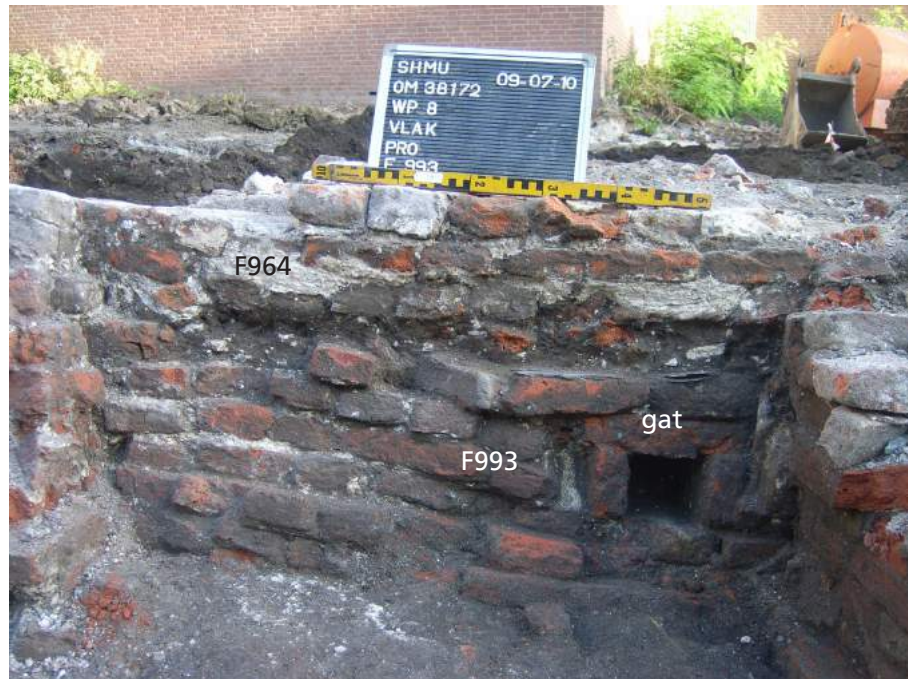
Afb. 4.96 Muur F993 waarin een goot is verwerkt. Aan de andere zijde van de muur bevindt zich het stelsel van goten en bezinkbakken F2025.
