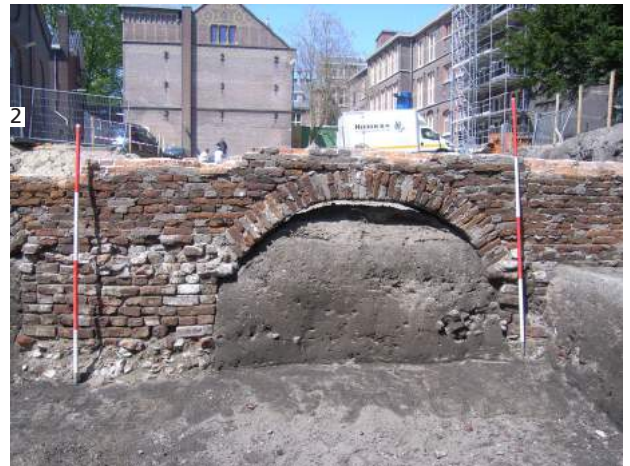
Afb. 5.12 Links (1) fundering van tuinmuur uit de 17 de eeuw ter plaatse van oudere waterloop, rechts grondbog (2).
