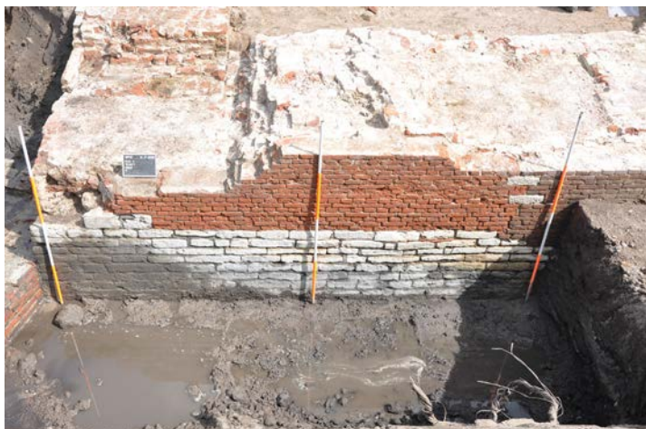
Afb. 28 Natuursteen schil F86 van gobertanger kalksteen bij de westelijke hoofdtoren, richting het oosten.
