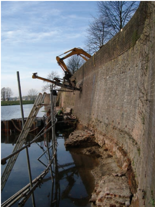
innovatieve technieken, grondvernageling en grondverankering
