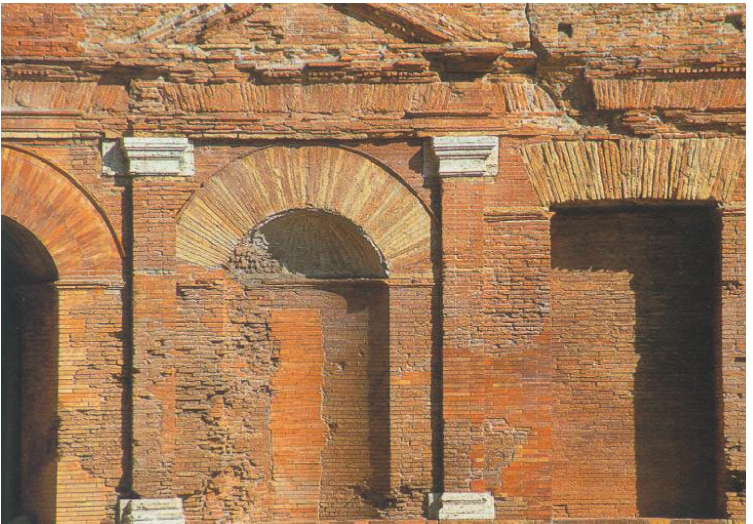
Bouwsporen en herstellingen in metselwerk, sprekend metselwerk
