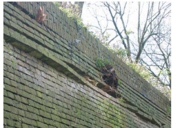
Boven en links: de vervormingen door natuurkrachten, bestaande muur Westwal
