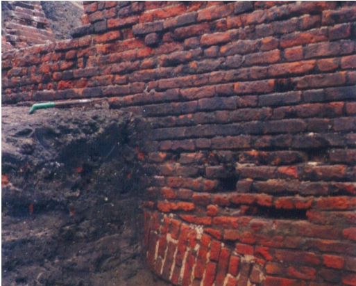
authentiek middeleeuws muurwerk
