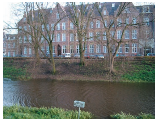
In 1897 begon de bouw van het neogotische Mariënburgtklooster. De Amsterdamse architect J.H. Groenendaal ontwierp het gebouw.
