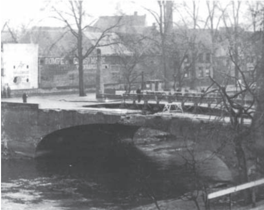
In 1944 vormde de Westwal de frontlijn in de gevechten bij de bevrijding van 's-Hertogenbosch. Het zuidelijk deel van de Westwal raakte toen ernstig beschadigd.
