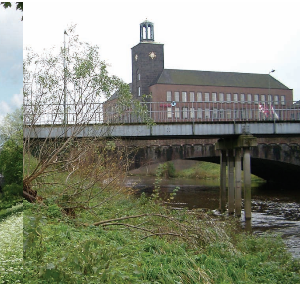
Vanaf talud van Westwal zicht op voetgangersbrug en Willemsbrug
