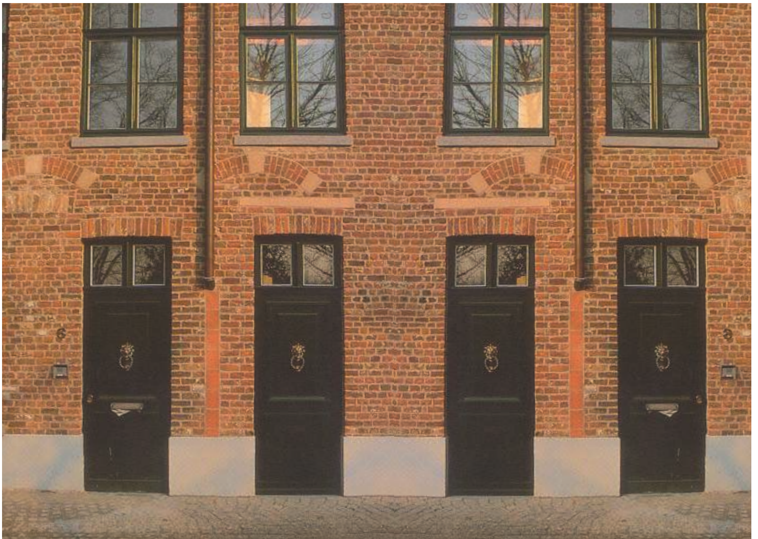
Bouwsporen en herstellingen in metselwerk, sprekend metselwerk
