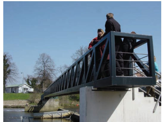
brug over stuw naar Vughtereiland
