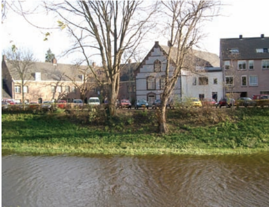
Berewoutkazerne met in het talud de te handhaven bomen ter plaatse van bastion Maria
