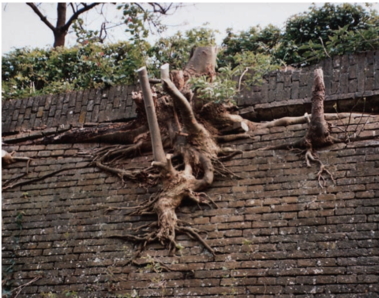
Boven en links: de vervormingen door natuurkrachten, bestaande muur Westwal
