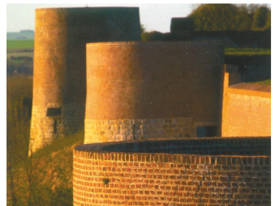
doorgaand metselwerk rondelen en walmuren, Montreuil-sur-Mer (Fr.)
