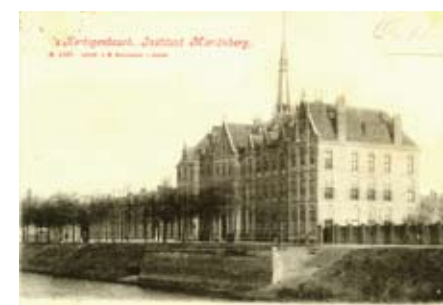
lange tijd is een muurdeel t.p.v. de Mariënborg gespaard gebleven om als landhoofd voor een brug te kunnen dienen; uiteindelijk is ook dit deel verdwenen
