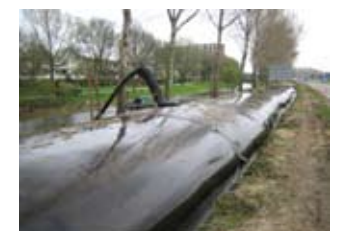
geotubes project Kruis Kamp 's-Hertogenbosch 2005
