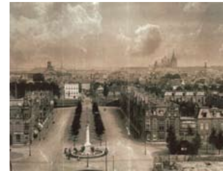
stationsbrug situatie rond 1904
