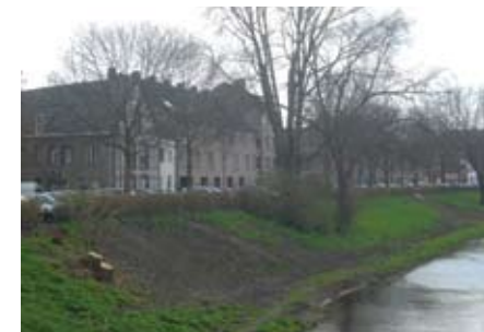
talud met daarin verborgen de aanzetten van bastion Maria
