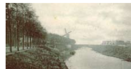
na kanalisering van de Dommeel zijn de herkenbare elementen verdwenen
