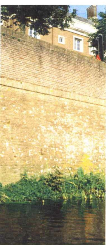
^ bouwnaad toont de afleesbare verhoging van de walmuur
