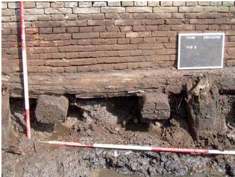
Afb. 8.1. Put 2 Funderingstechniek met balken en palen constructie. De palen onder de dwarsliggers zijn op de foto niet te zien.
