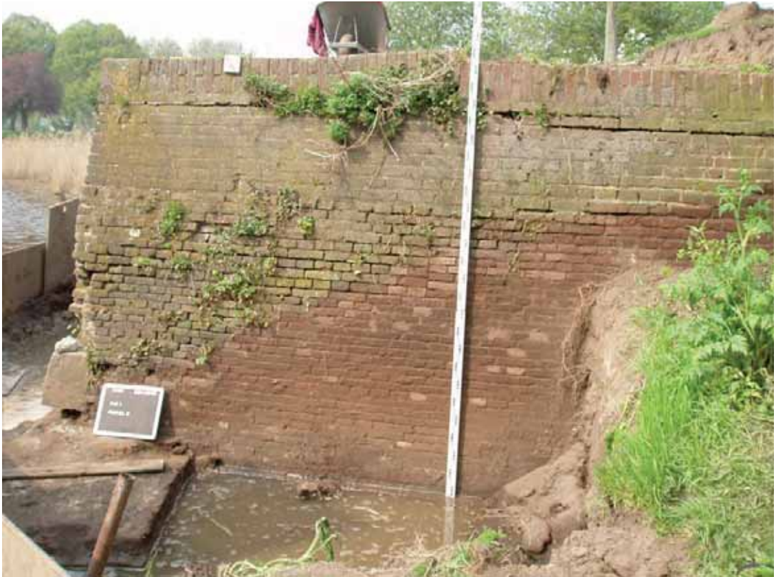
Afb. 9.1A. Put 1, profiel 6. De oranje kleur van de stenen geeft de taludlijn aan. De planken fundering is gelijk met de waterlijn, alleen de steunpaal is zichtbaar. Links naast de baak is de bouwnaad te zien. De originele rollaag valt rechts net buiten de foto. Een afdruk van het originele talud en rollaag is te zien op afbeelding 9.1B. Afbeelding 9.1C laat het bovenaanzicht van de originele rollaag zien.
