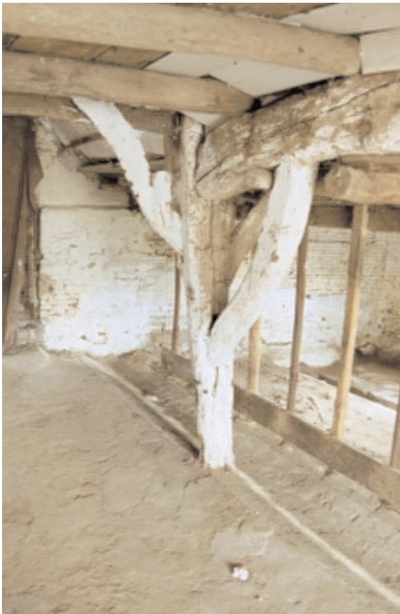
Afb. 21. Stijl (A) met korbeel (D), ankerbalk (B) en windverbanden (C) van het derde gebint (straat-zijde). (E = balken van de slietenzolder, F = voergoot).
