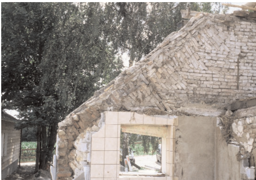
Afb. 3. Na sloop van allerlei delen is de kopgevel beter zichtbaar. De gevel is na het verplaatsen (naar binnen) van de achtergevel verhoogd en is een nieuwe hoek met de achtergevel gemaakt. Het vlechtwerk is daardoor anders beëindigd dan gebruikelijk.
