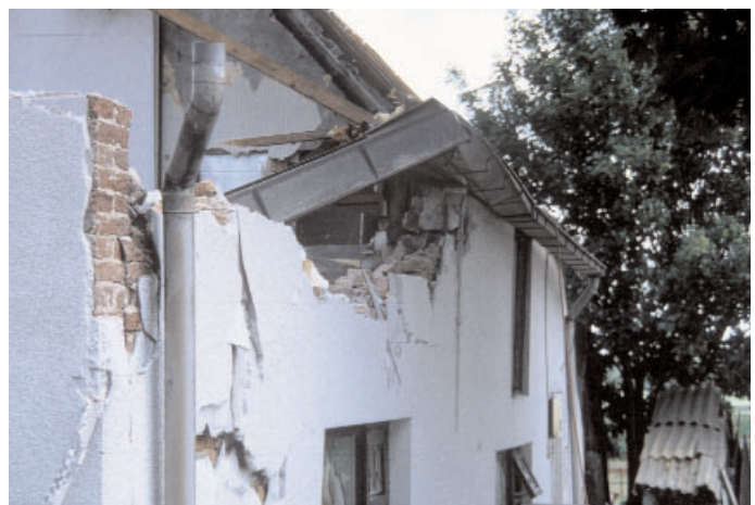
Afb. 6. Op de hoek van de straatgevel en kopgevel van het woongedeelte zijn de 18de en 19de eeuwse handvorm bakstenen zichtbaar. Deze gevel is in deze periode veranderd van een lage straatgevel naar een hoge kopgevel.
