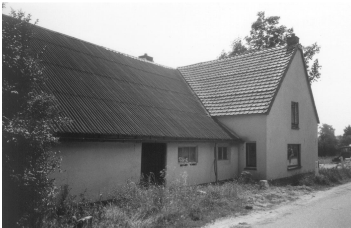
Afb. 9. Straatgevel aan de dijk
