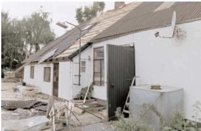
Afb. 11. Achtergevel tijdens het ontmantelen van de kap.
