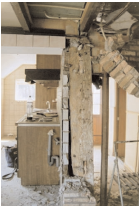
Afb. 13. Stijl van het eerste gebint in het woongedeelte, weggewerkt in de gangmuur tussen gang en keuken.
