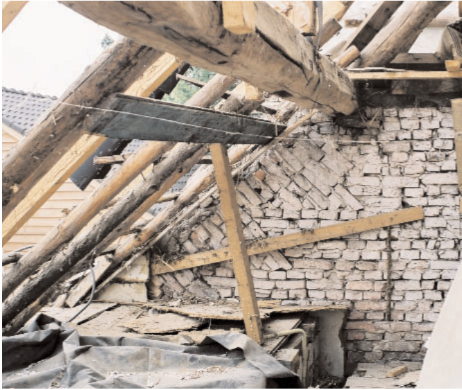
Afb. 2. Binnenzijde van de kopgevel van het woongedeelte; de fliering eindigt in de gevel maar bevat bouwsporen in de vorm van pengaten waarin een reeds verdwenen stijl (A) en windverband (B) hebben gezeten. In eerste opzet heeft de boerderij een vakwerk- of houten gevel gehad.
