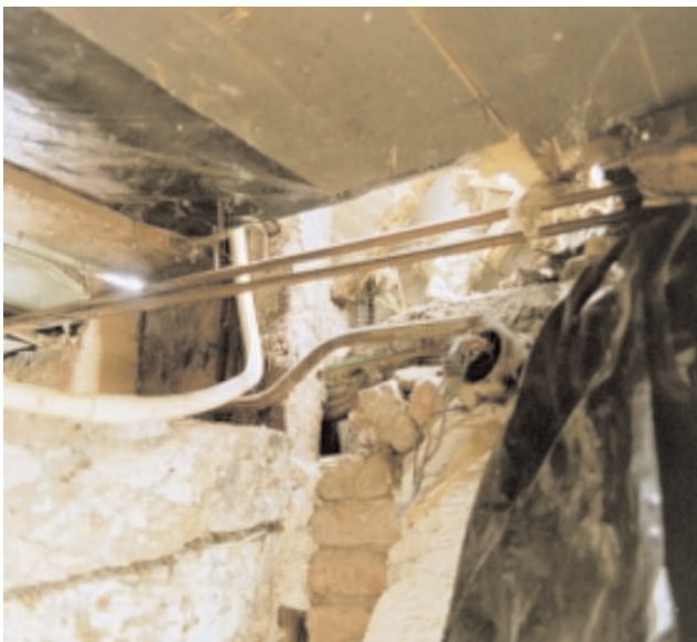
Afb. 7. Stijl (A) en ankerbalk (B) met windverband (C) van het eerste gebint (ook afb. 13), op de ankerbalk hebben de kinderbinten van de zoldervloer gelegen. Van deze binten is er nog één in situ aanwezig (D).
