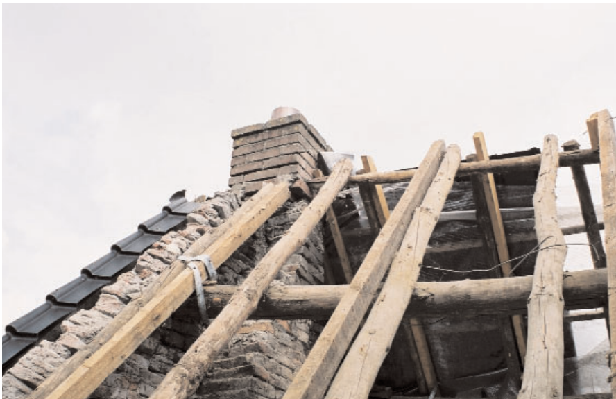
Afb. 8. Top van de gevel aan de straat waarin, evenals elders, vlechtwerk in de schuine geveldelen is toegepast.
