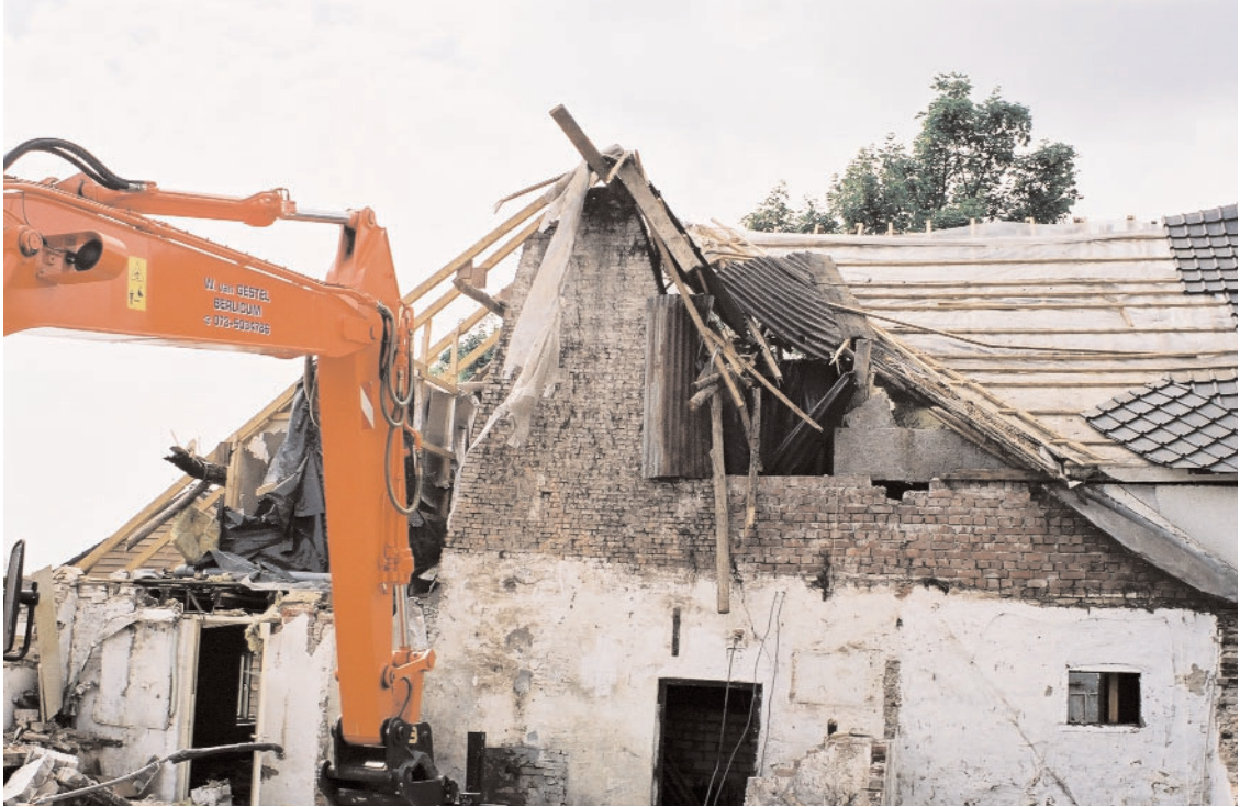
Afb. 1. Achterkant (stalzijde) van het rookkanaal van de brede schouw in de herd. Op de schouw sluiten aan beide zijden lage muren aan die dienst doen als brandmuur. Na de verbouwing van de straatgevel en verhoging van vloer en plafond is de brandmuur iets verhoogd.
