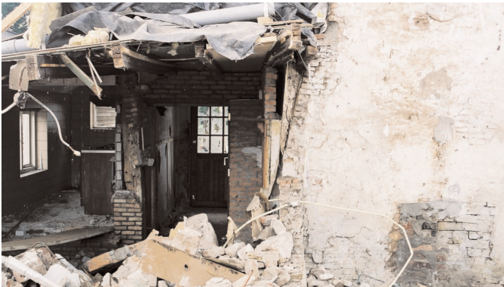
Afb. 15. Een levensechte dwarsdoorsnede achter de schouw, gezien naar de kopgevel van het woongedeelte. In de schoorsteen is de dichtzetting waarneembaar van de stookopening voor de bereiding van het voer. Links is de stijl van het eerste gebint waarneembaar op de scheiding van keuken en gang.
