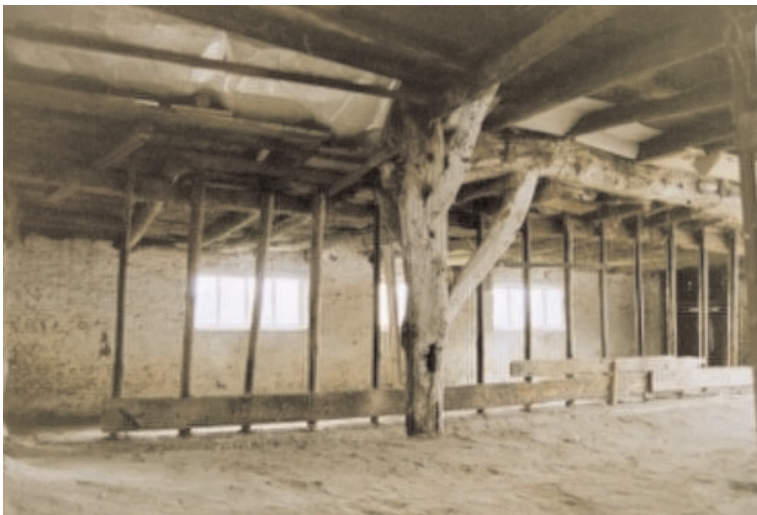
Afb. 17. Bedrijfsgedeelte met opstelplaats voor dieren achter de voergoot en stalrepels.
