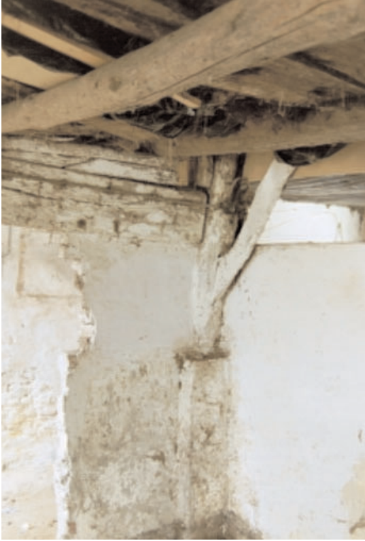
Afb. 19. Ingekorte stijl met ankerbalk en windverband van het tweede gebint (straatzijde).
