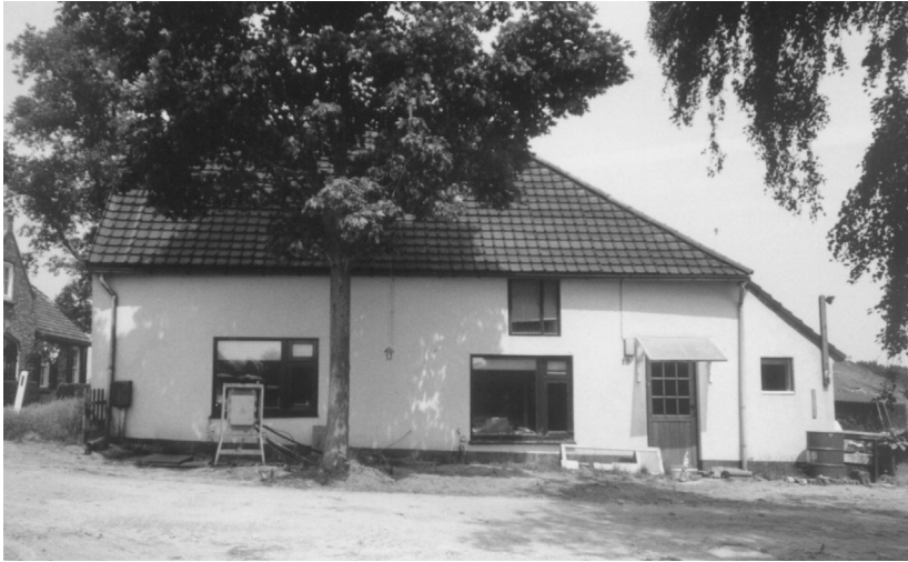
Afb. 12. Kopgevel van het woongedeelte.
