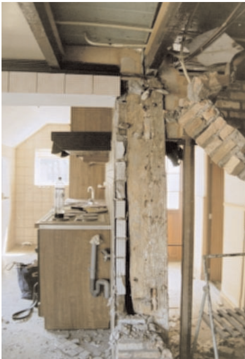
Afb. 16. Stijl van het eerste gebint in het woongedeelte, weggewerkt in de gangmuur tussen gang en keuken.
