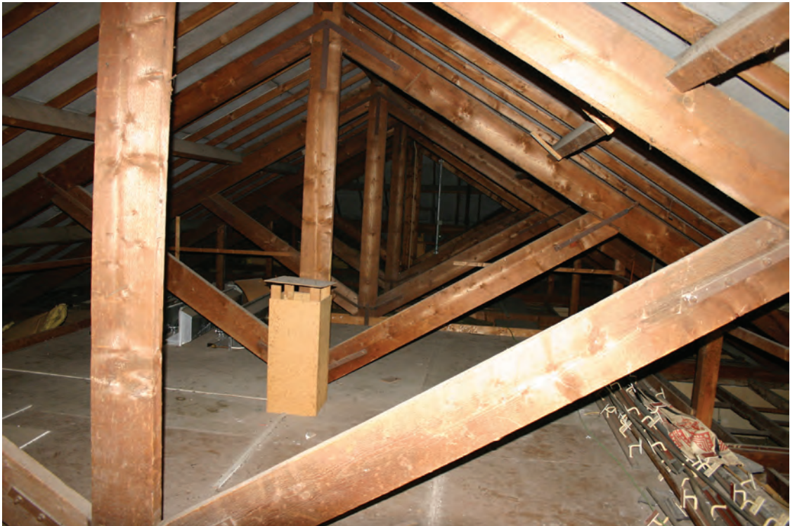
De hangspanten in de kap.
