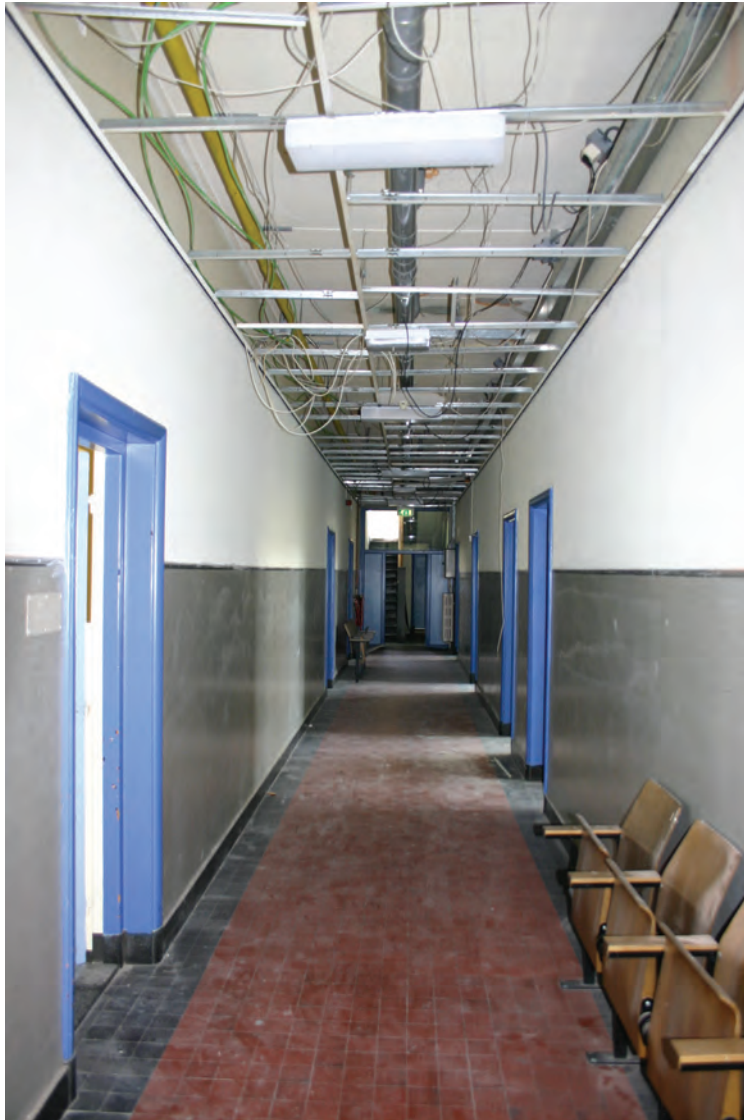
De gang op de begane grond. Op basis van de positie van de deurkozijnen is vast te stellen dat de vertrekken op de begane grond aanzienlijk groter waren dan op de verdieping.
