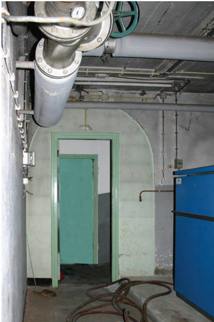
Jaren vijftig deur in een opvulling van een oorspronkelijke doorgang. Kelderdek met bekistingsporen.
