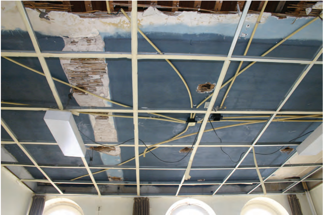
Nogmaals een stucplafond, hier met sporen van een muur die onder het bestaande plafond is aangebracht, en later ook weer is verwijderd.
