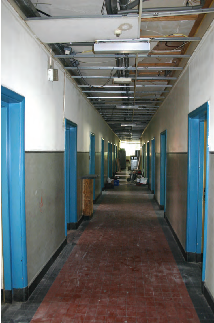
De gang op de eerste verdieping. Aan weerszijden nog de authentieke deurkozijnen, boven het gedeeltelijk gedemonteerde systeemplafond nog het oorspronkelijke stucplafond.
