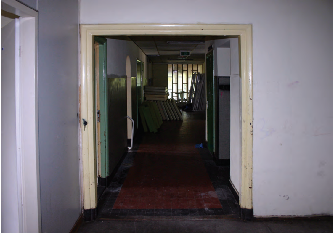
De tweede verdieping gezien in westelijke richting. Op de voorgrond, links een nieuw deurkozijn. Centraal een oorspronkelijk deurkozijn. De deuren zijn verdwenen.
