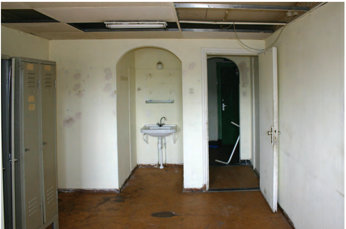
Op de tweede verdieping zijn nog enkele kamers met een indeling.
