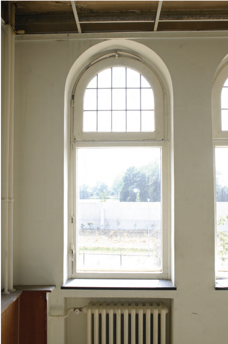
Een van de vensters in de voorgevel van het gebouw. Let op het sluitingsmechanisme van de bovenramen en de radiatornissen.
