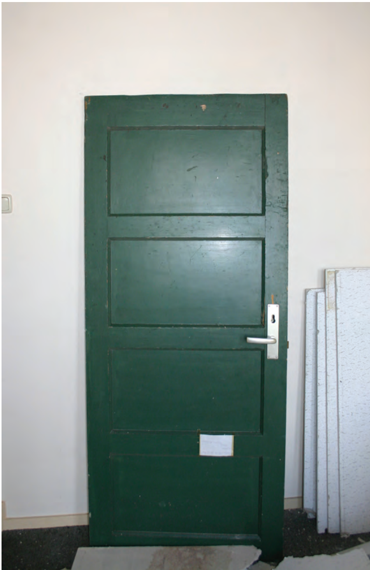
Een authentieke paneeldeur, zoals deze in situ alleen in de kelder nog aanwezig zijn. (afbeelding 20)
