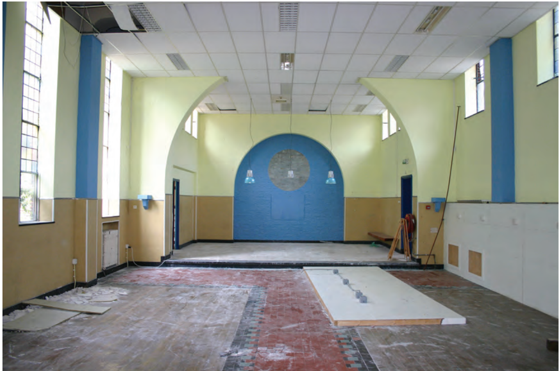
De kapel gezien in de richting van het koor. Details zijn de vloer, de triomfboog en de volledig afgewerkte draagconstructie.
